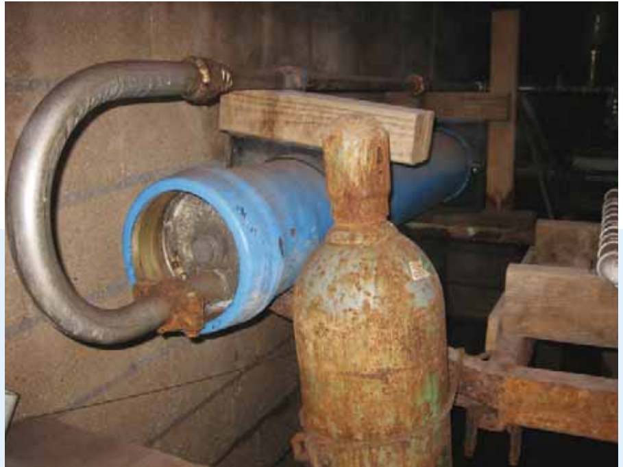
RO-module voor drinkwaterproductie op Saba.
