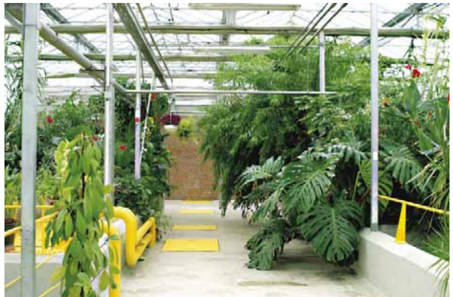
Het ecologische afvalwaterzuiveringssysteem.
