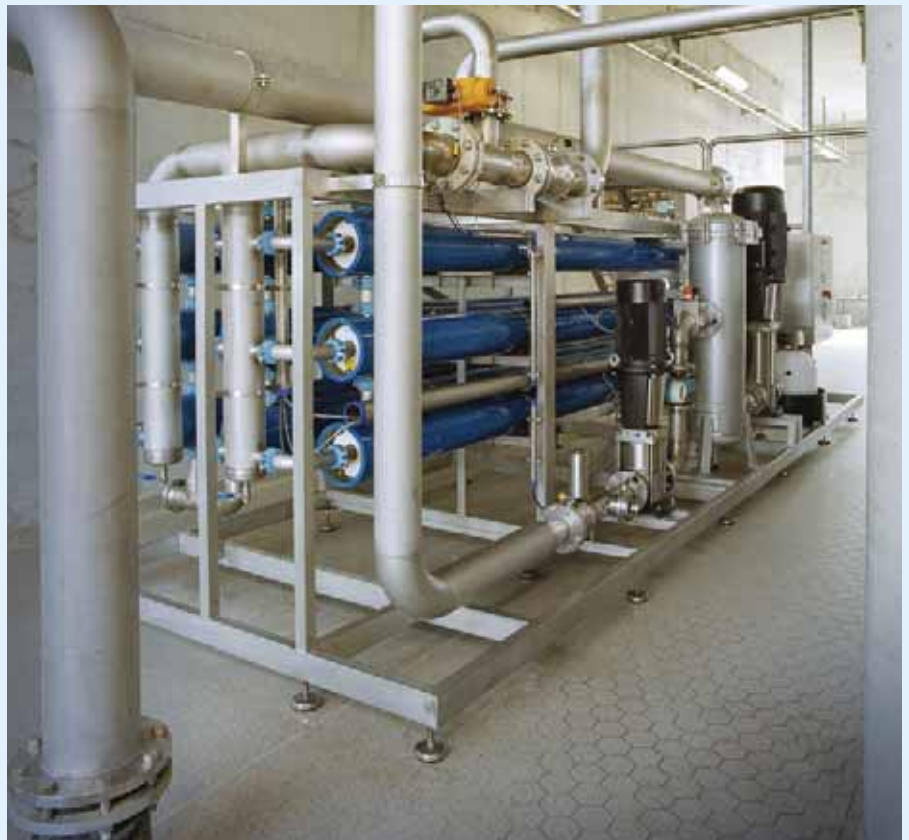
Membraanmodules van een MBR.
