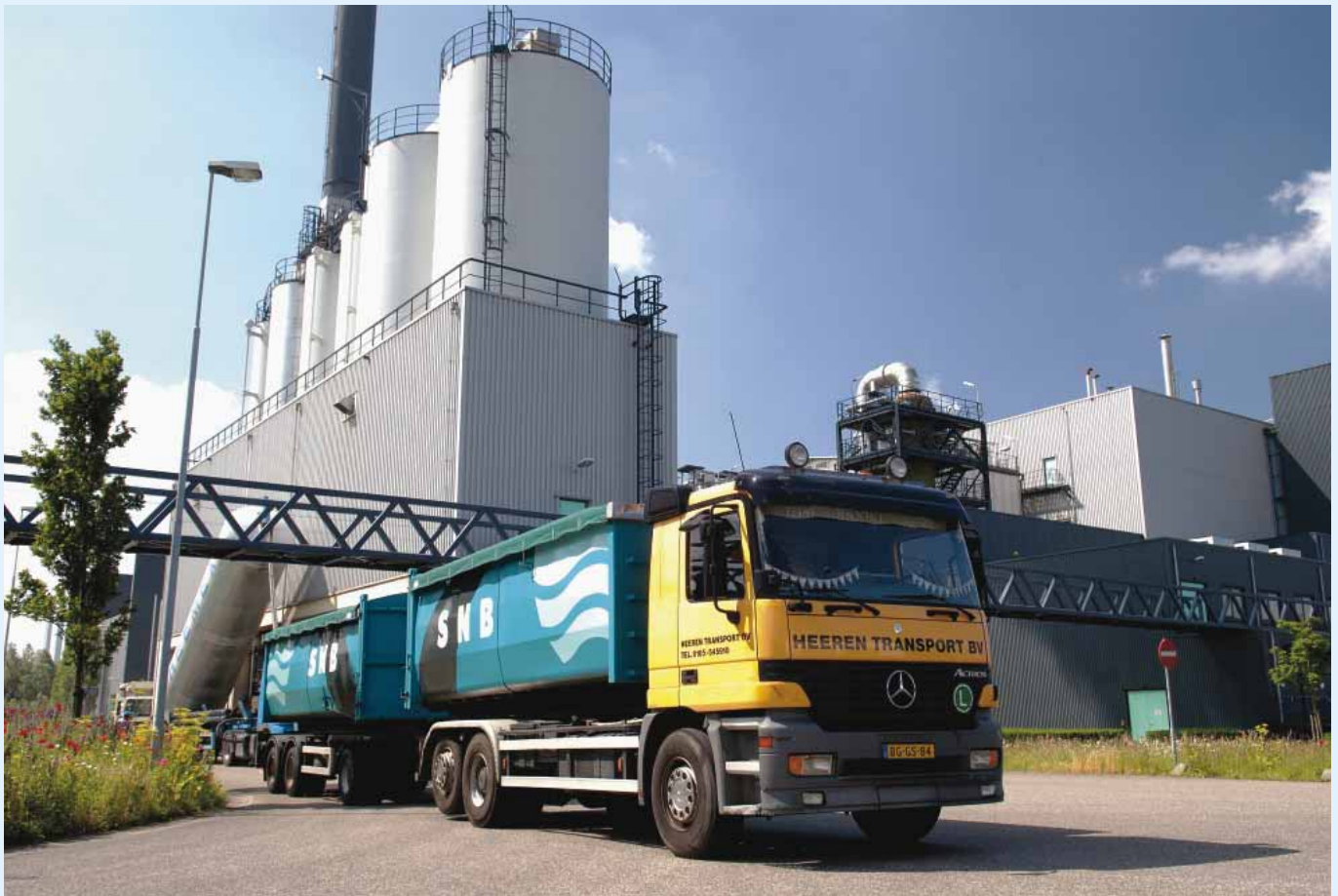
De slibverwerkingsinstallatie in Moerdijk.
