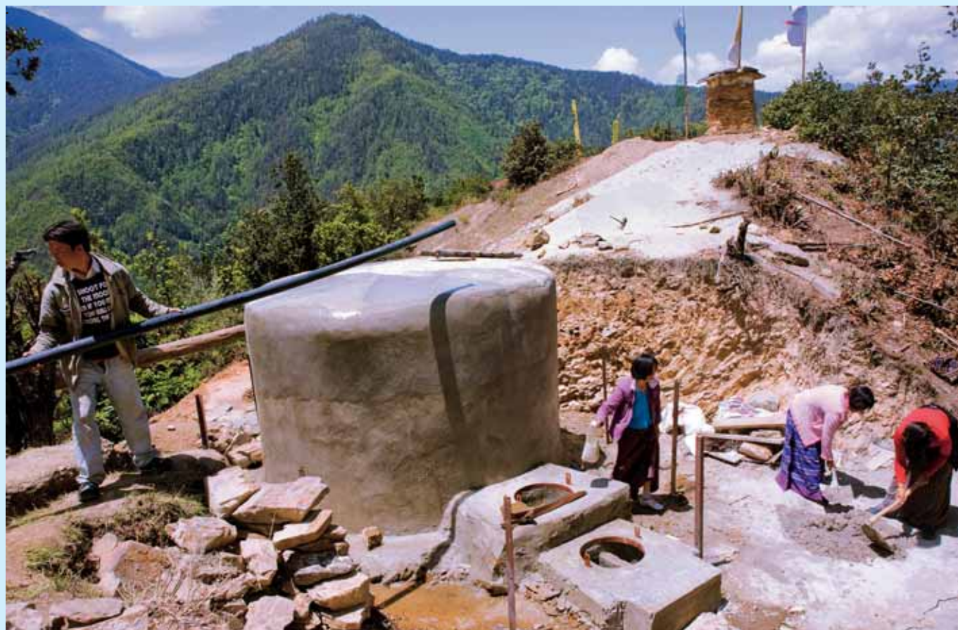
De aanleg van een waterreservoir.
