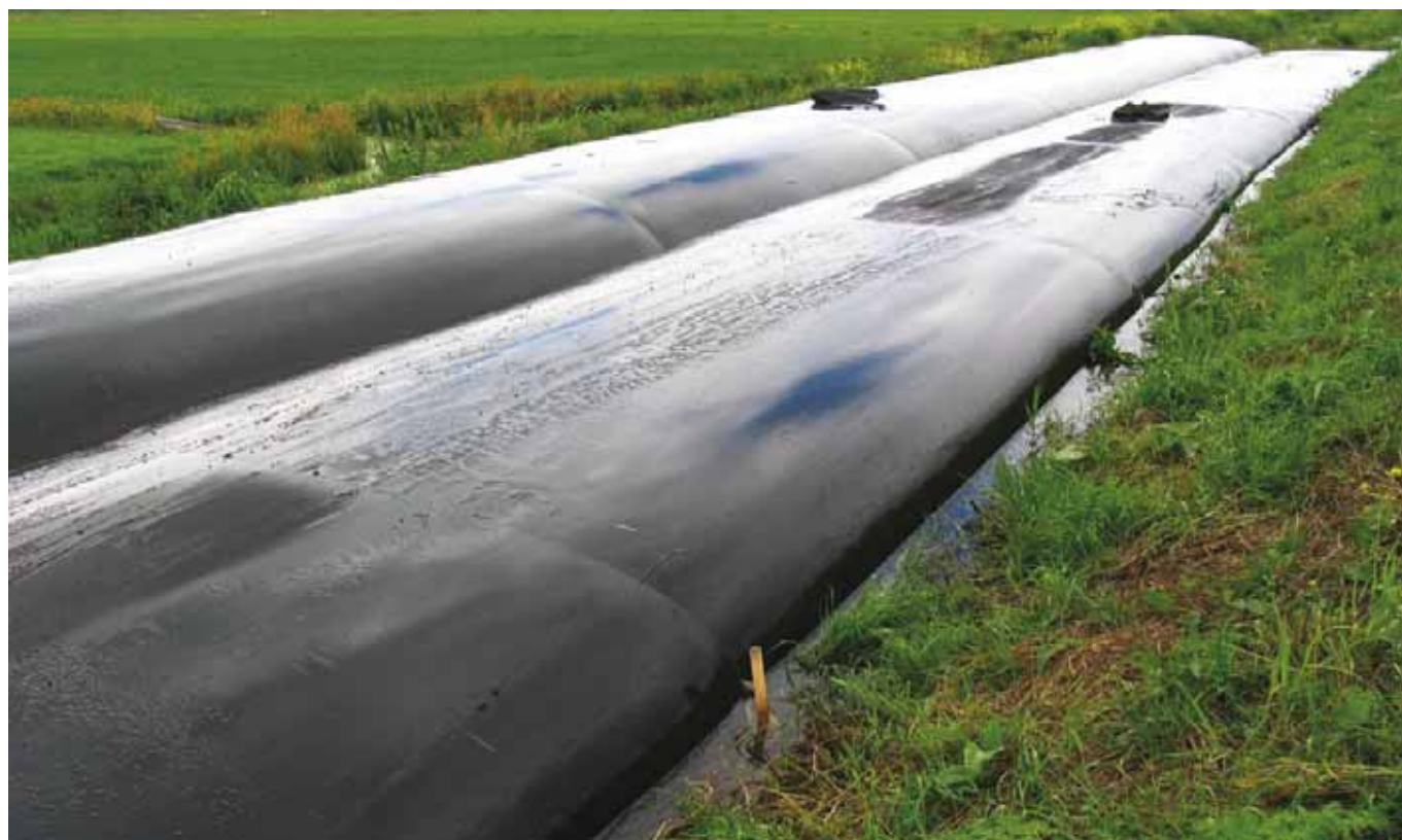
De gevulde baggertubes.
