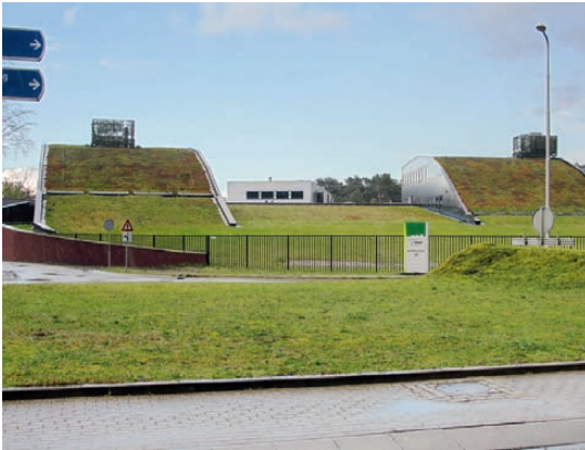
Afbeelding 1 – Groen dak op een woning (boven) en op een bedrijventerrein (onder)
