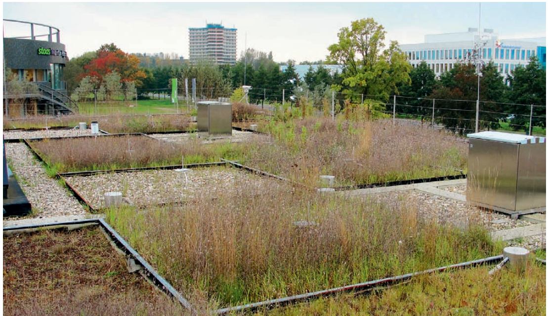
Afbeelding 17 – Onderzoek op experimentendak NIOO-KNAW naar gecombineerde effecten van warmte- en koude-isolatie, biodiversiteit en hydrologische werking i.s.m. Wageningen Universiteit, Waterschap Vallei en Veluwe, Rotterdam, ZinCo Benelux, Daklab/BetonRestore, Stichting RIONED en STOWA
