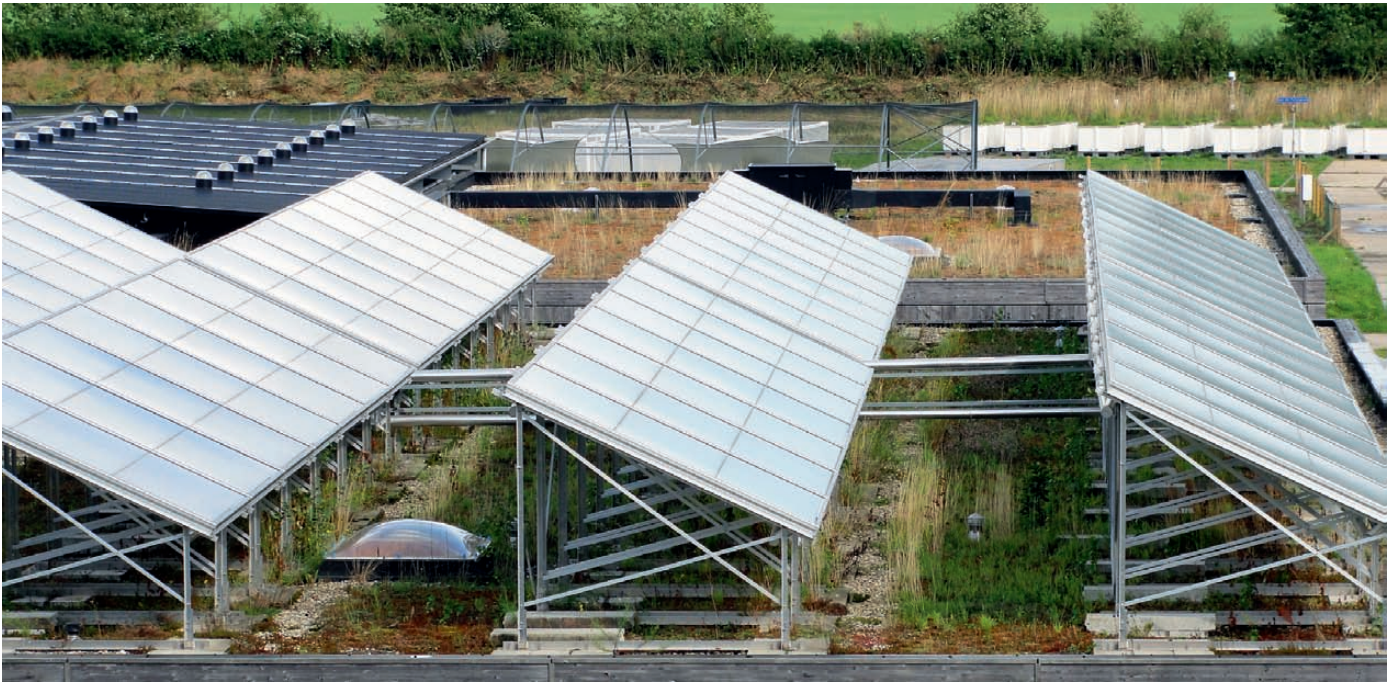
Afbeelding 14 – Groen dak met positief effect op opwekking van zonne-energie
