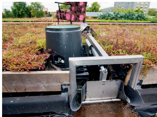
Afbeelding 7 – Elementen om afvoer bij de dakuitlaat te reguleren door afvoertraging (links, foto BetonRestore) of door sturing met overloop (rechts, foto Polderdak © Merlijn Michon)
