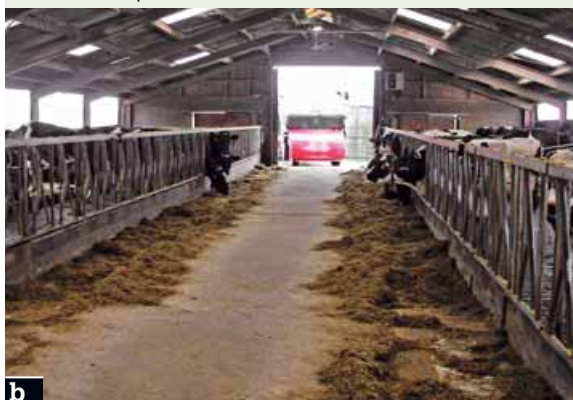
Foto 5 Con i sistemi automatici per l'unifeed (a) la larghezza della corsia di foraggiamento può essere ristretta di circa il 50% rispetto a quanto necessario per il transito di carri miscelatori (b)
