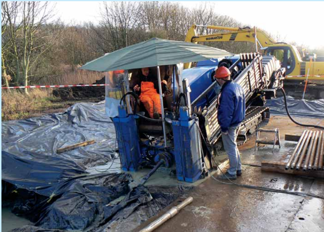
De boring in Nieuwegein, eind november.
