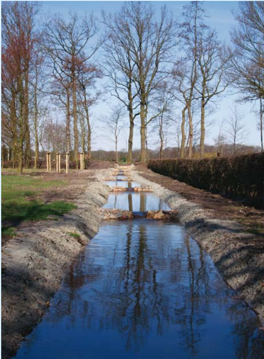
Het aanleggen van een vistrap over een oorspronkelijk als bouwkegel gereserveerd stuk grond biedt echter uitkomst.
