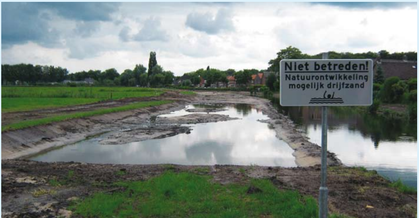
Na de werkzaamheden aan de Zandwetering.
