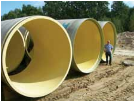
De buizen van HOBAS met een doorsnede van drie meter.
