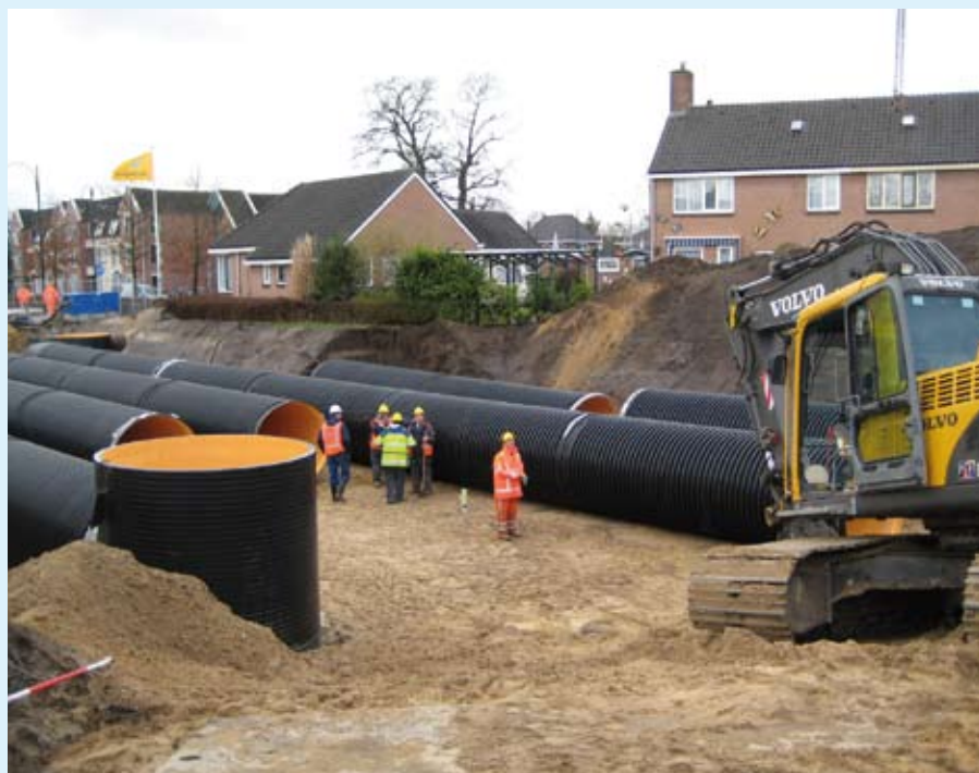
Afkoppelen in Leersum in 2009: de aanleg van een grote infiltratieverzamelleiding.
