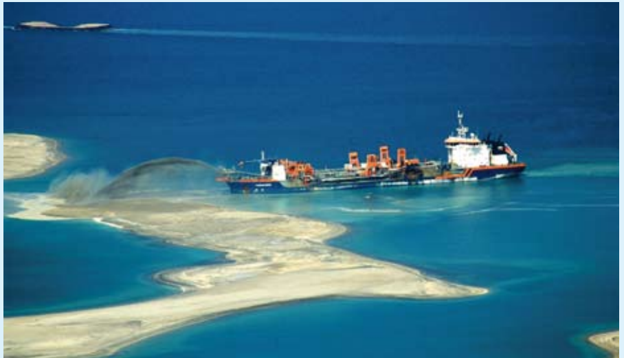
Van Oord aan het werk voor de kust van Dubai.
