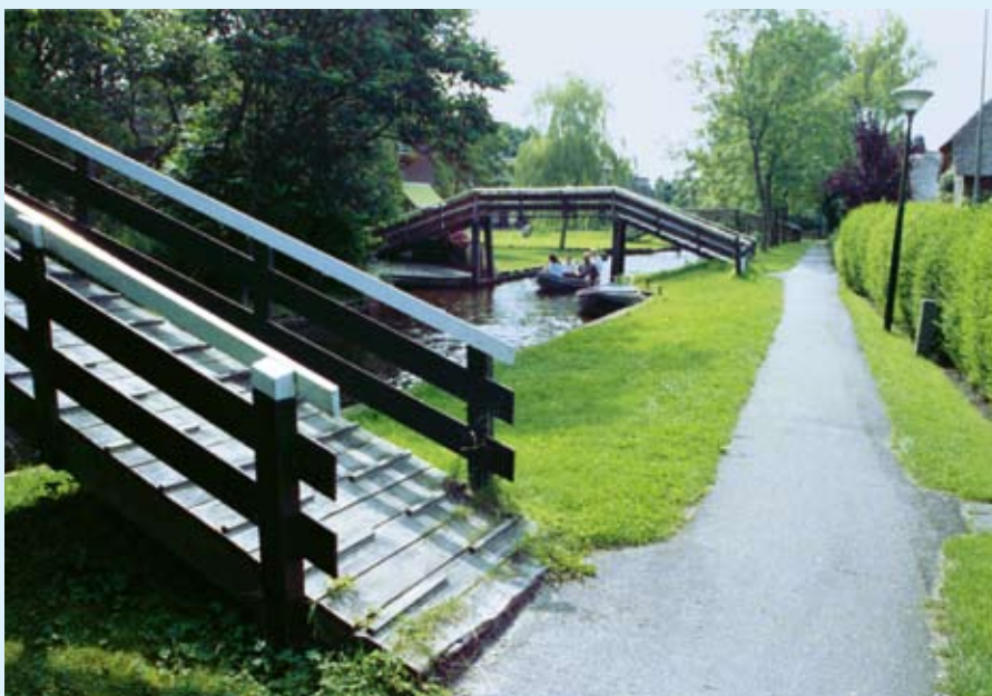
De structuur van oevers, vaarten en bruggen zijn karakteristiek voor Giethoorn.
