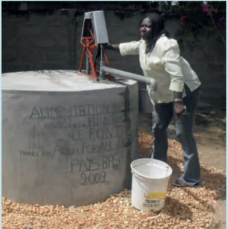
Afgesloten putten met touwpomp zorgen ervoor dat er geen vuil in het water kan komen.
