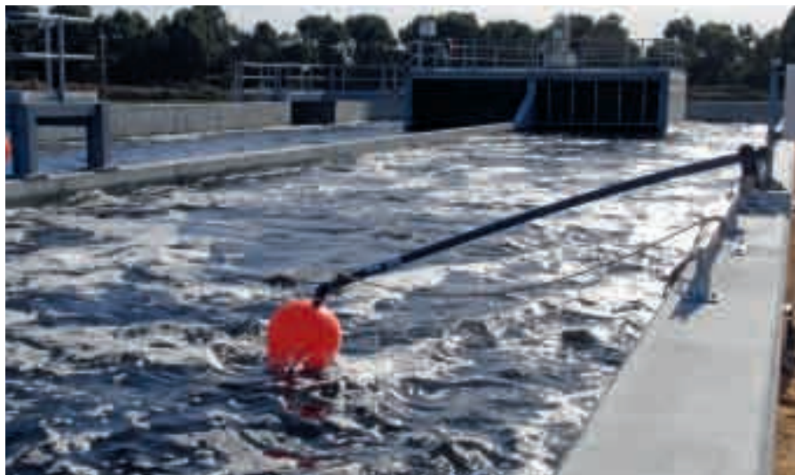
Een on line analyser in een beluchtingstank.
