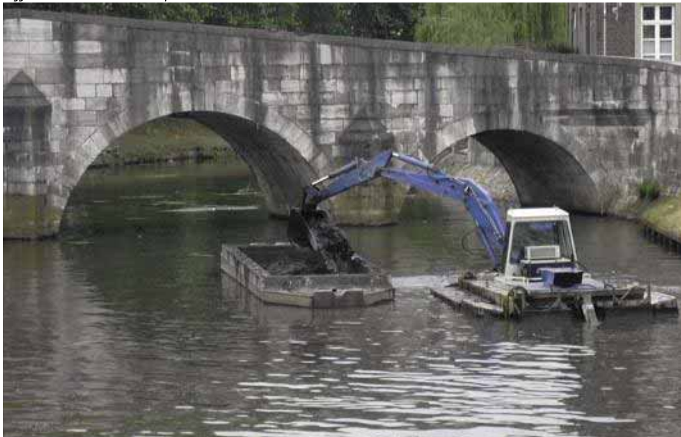
Baggerwerkzaamheden door Waterschap Roer en Overmaas in Roermond.
