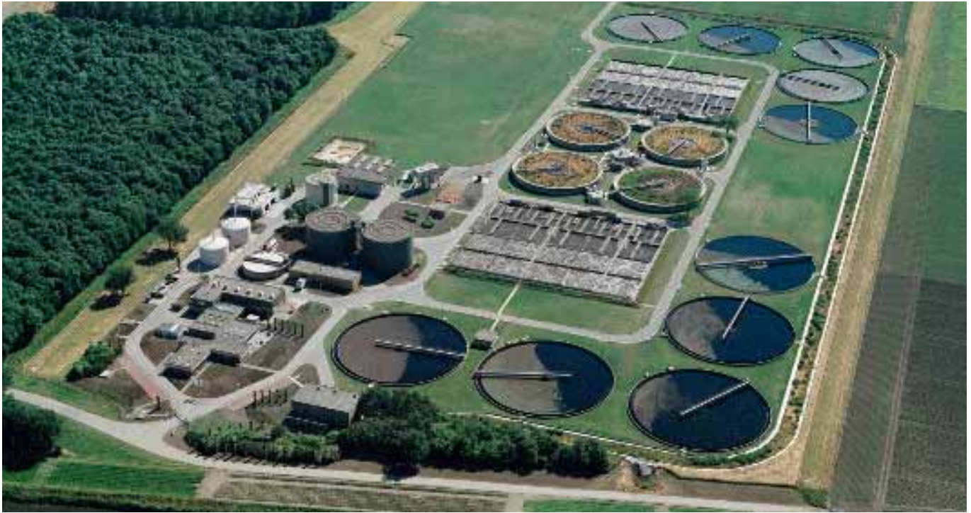
De rioolwaterzuiveringsinstallatie in Bath.
