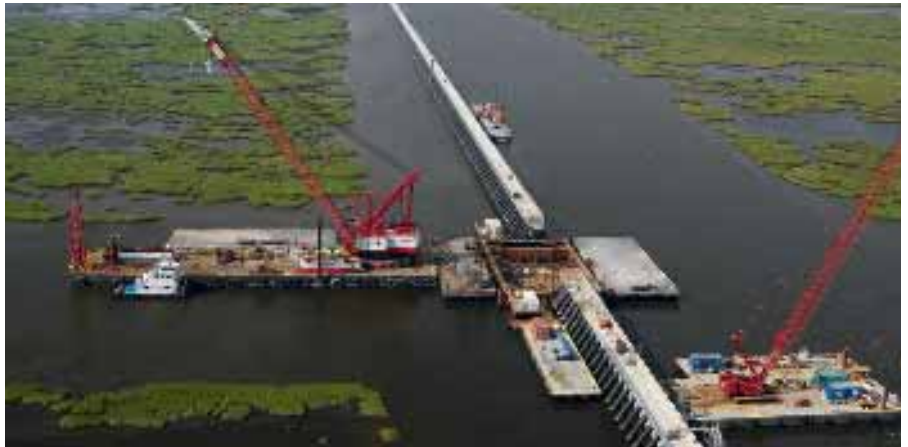
Werzaamheden om New Orleans te beschermen tegen nieuwe overstromingen (foto: Royal Haskoning)
