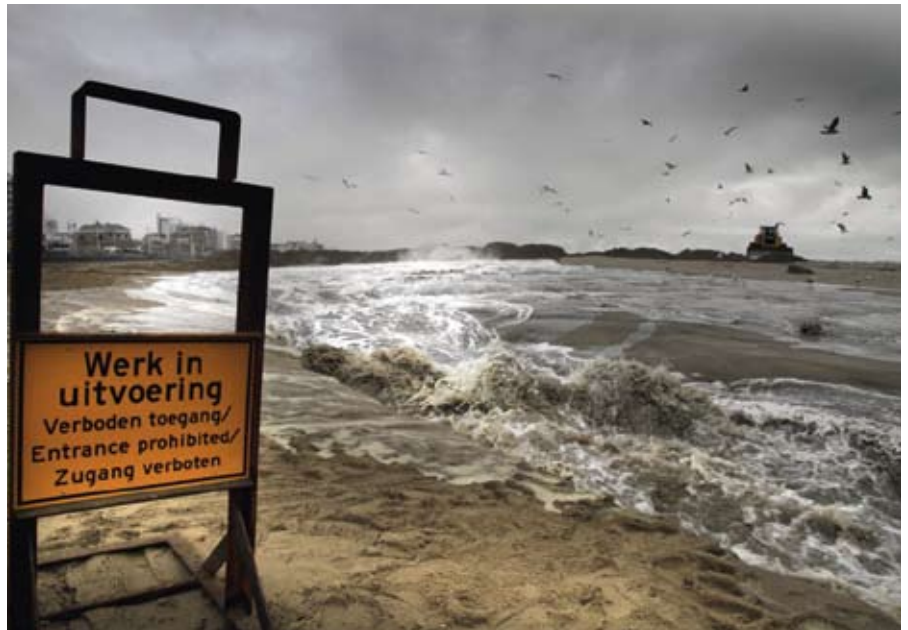
Het strand van Scheveningen wordt 40 tot 70 meter breder. Begin dit jaar werd 1,5 miljoen kubieke meter zand opgespoten, vanaf begin november komt daar nog eens 1,1 miljoen kubieke meter bij. Tegelijkertijd wordt in de nieuwe dijk een nieuwe boulevard gebouwd (foto: Peter van Oosterhout).
