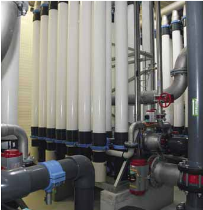
Het interieur van de membraanbioreactor (foto: Piet de Wolf).
