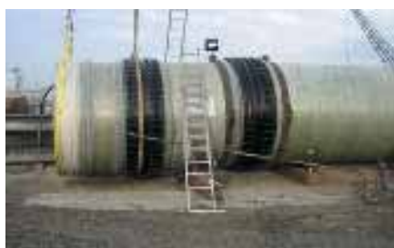
Een voorbeeld van de koppelingen die tien meter onder de grond geplaatst worden.
