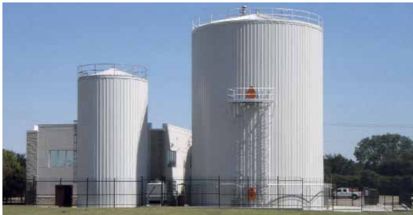
De anaerobe MBR-installatie in Texas.
