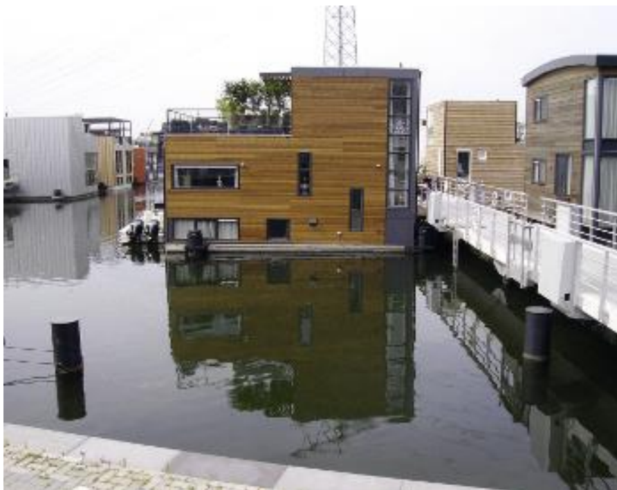
Drijvende woning aan vaste steiger in Amsterdam (IJburg).
