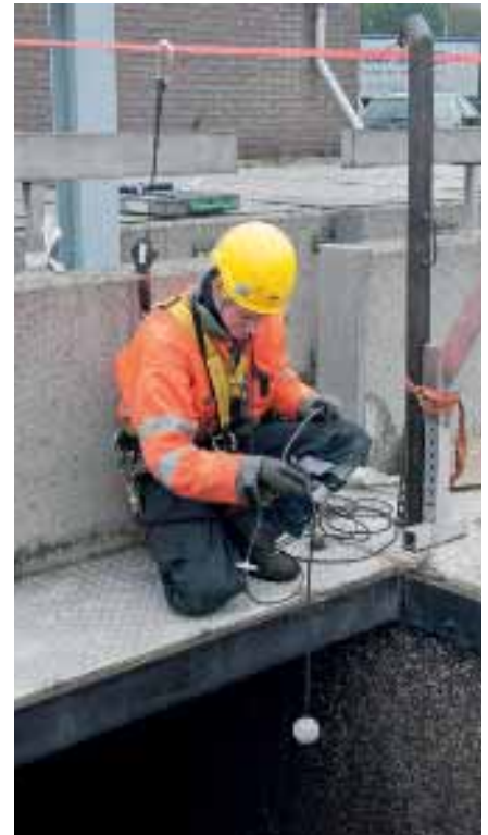
Onderhoud aan het influentgemaal van de rwzi Apeldoorn (foto: Benno Wonink).
