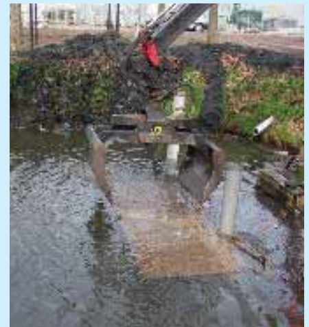
De plaatsing van een Mudtrap.
