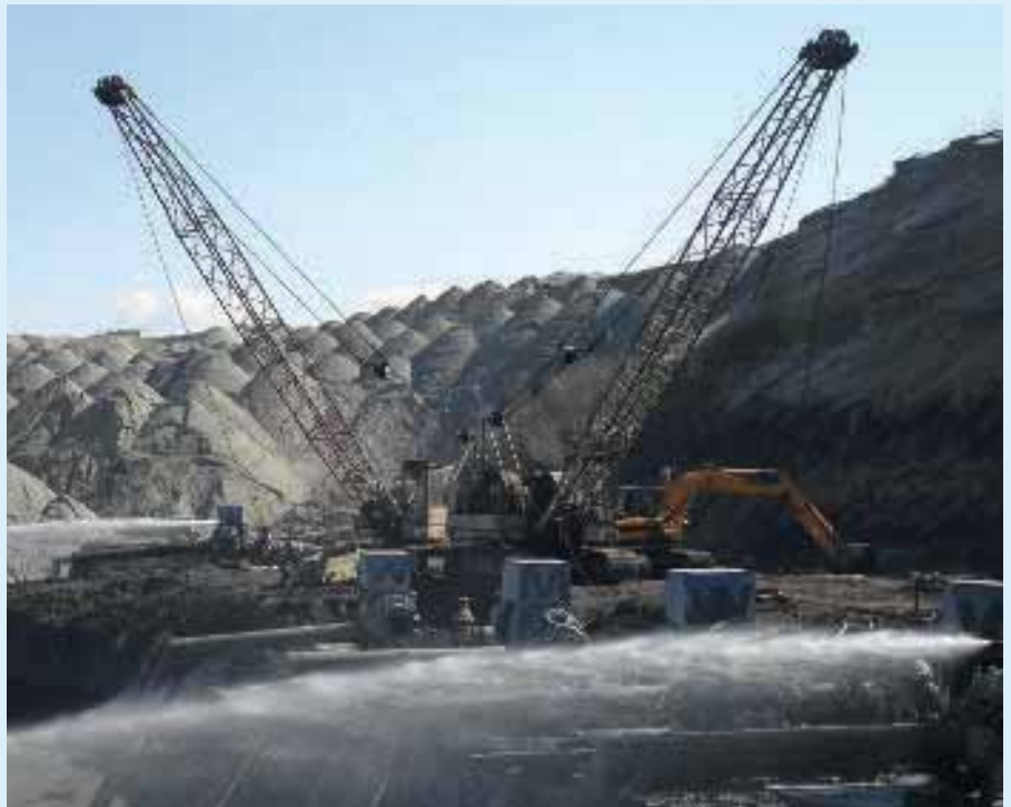
Grondwateronttrekking bij de energiecentrale Rovinari.
