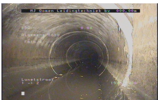
Afbeelding 2. Inspectiebeeld binnenkant leiding door robotcamera (links) en fysieke leidinginspectie door inspecteur (rechts)
