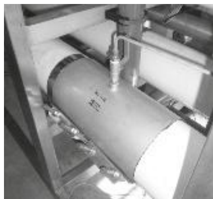
Een aanboring op een al bestaande installatie (de onderzoekslocatie van NieuWater bij Norit Klazienaveen) en één waarbij de sensor al is geïntegreerd in de drukbuis (nieuwe locatie NieuWater: Puurwaterfabriek te Emmen).
