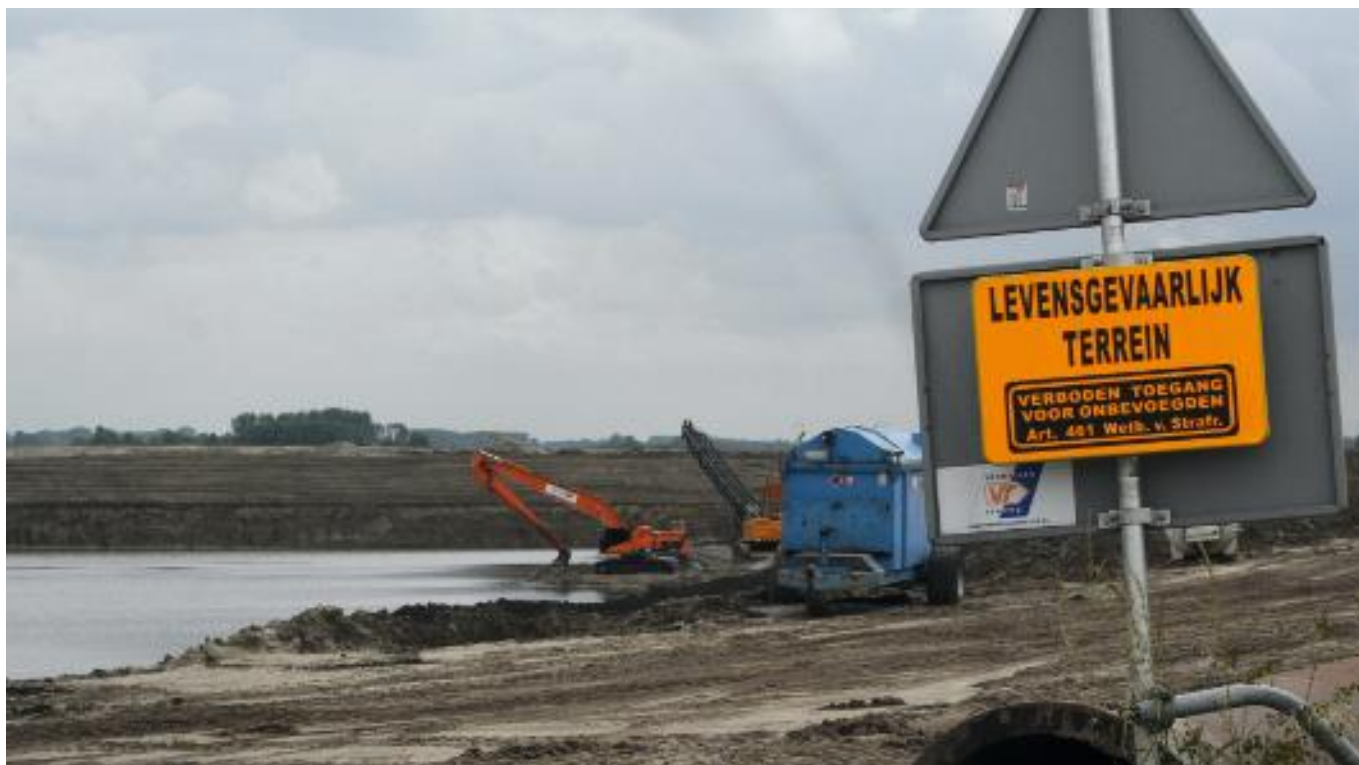
Het afgraven van grond in de Overdiepse Polder.
