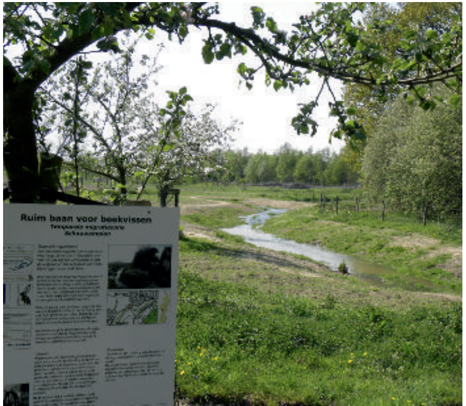
Een natuurlijk ingerichte bypass is alleen bij hogere afvoeren in gebruik. Het is voldoende voor vismigratie. De rest van het jaar fungeert de laagte als een beekmoeras (foto: Hans de Mars, Royal HaskoningDHV).
