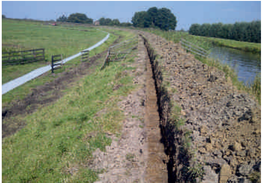
De mat met temperatuursensoren voordat die ingegraven werd in deze dijk in Woerden.
