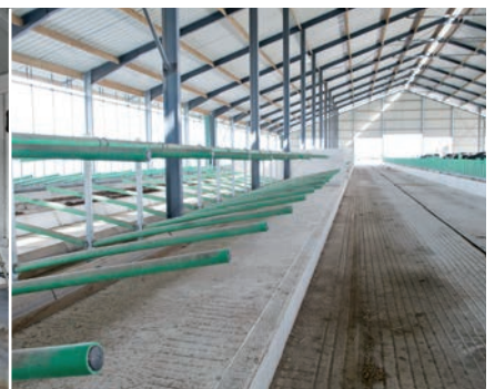
Behalve het voerhek zijn ook de ligboxen uit flexibele kunststof vervaardigd
