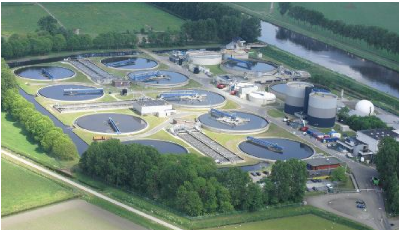
De huidige rioolwaterzuiveringsinstallatie Garmerwolde (foto: Petra Schuil).
