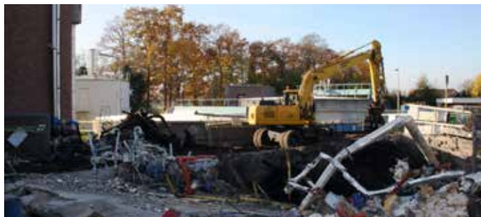
De installatie in Raalte functioneerde weer grotendeels binnen 24 uur
