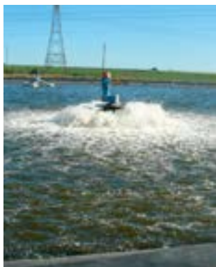
Beluchting op de rioolwaterzuivering bij Komatipoort, een plaatsje in Zuid-Afrika, net voor de grens met Mozambique
