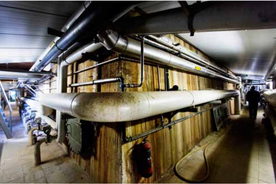
Onderdelen van het proces in beeld. Linkerpagina: afvoer van proceswater van Aviko. Boven: afgesloten tank voor anaerobe voorbehandeling
