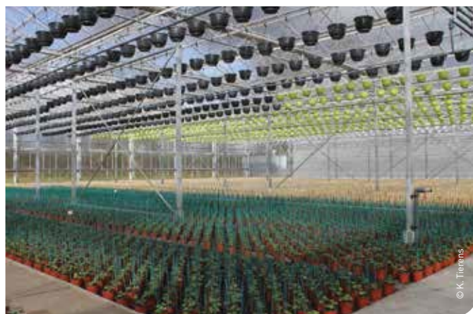
▲ De nieuwe serre wordt optimaal benut
