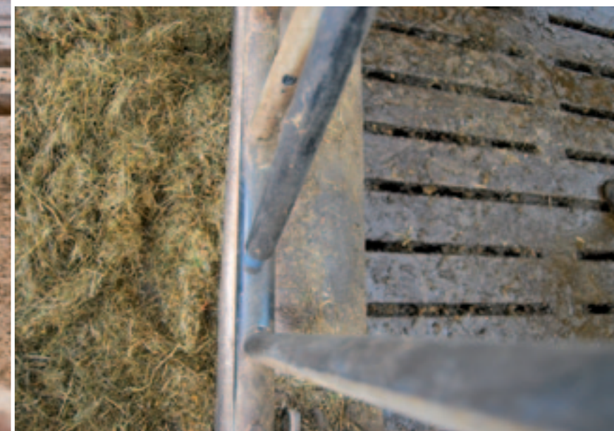
De voergang van Theo Huisjes ligt 20 cm hoger dan de roostervloer. "Dat had zelfs 25 cm mogen zijn, dan bleven ze achter het voerhek."
