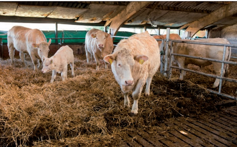
Van ligboxenstal naar strosstal betekende beton storten op de roostervloer tussen de boxdekken
