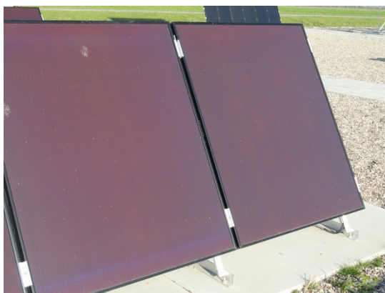
Foto 4: dunne film silicium panelen van Schott
