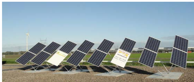
Foto 9: Van der Valk solar-tracker (over 1 as)
