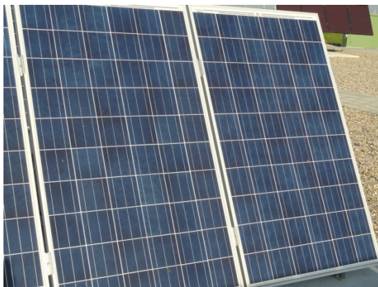
Foto 2: polykristallijn silicium panelen van Solarpark
