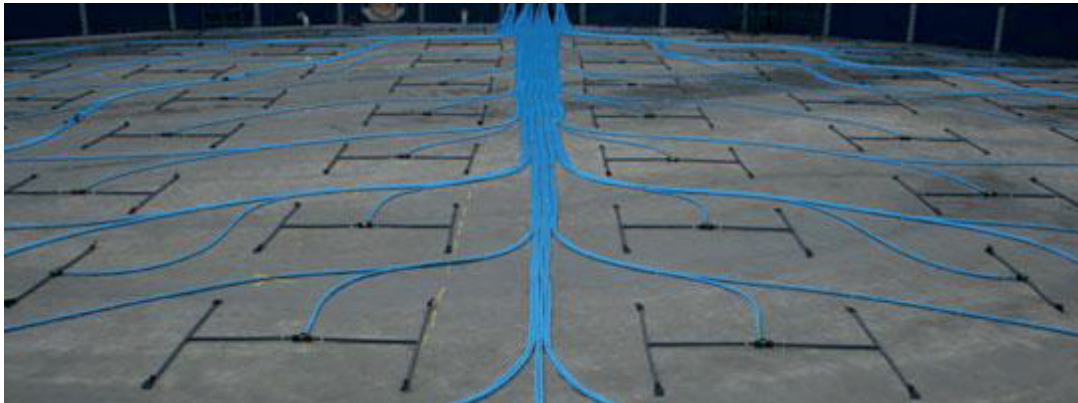
Figuur 2.1 Voorbeeld van de aanleg van het Aeromix systeem op de bodem van een mestopslag; tyleneleidingen (blauw) met verdeelstukken met 4 uitblaasopeningen (zwart). (Bron: Ameram Ltd.)
