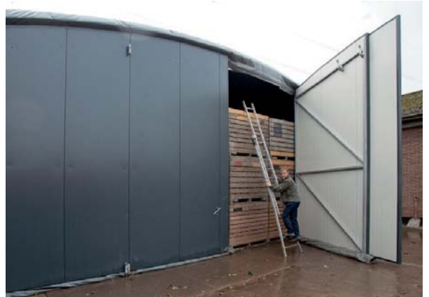
Bij de MDI ontbreekt een drukvaste achterwand. Toen Mol er voor de eerste keer uien in reed, maakte hij een drukvaste achterwand van kisten gevuld met uien.
