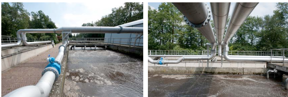
Afbeelding 3. Leidingwerk voor koppeling megablock – rwzi
