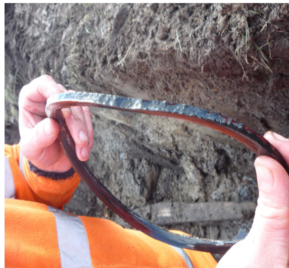
Afbeelding 4. Aangetaste rubberen afdichting uit AC leiding
