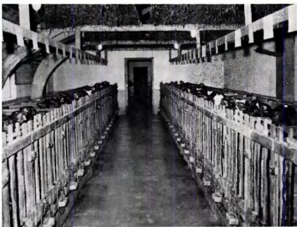
Overzicht van een kalverstal. De zoldering is van riet. In het midden hiervan is een opening die dienst doet bij de ventilatie
