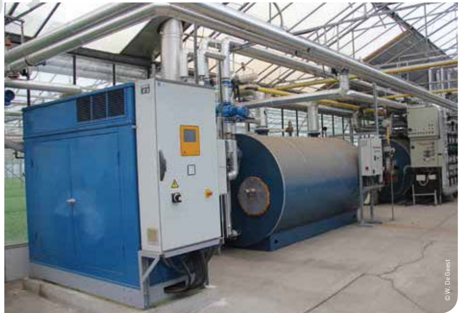
▲ De mini WKK bij Kristof Van Laere is essentieel om te komen tot een optimale energiebenutting
