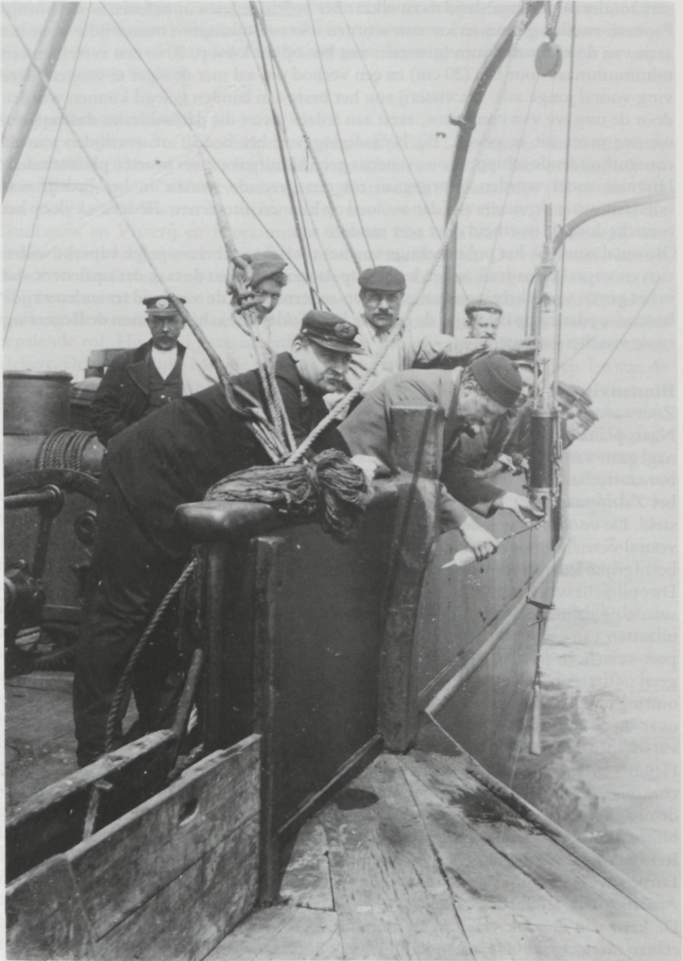
Voor de bepaling van het zoutgehalte werd gebruik gemaakt van speciale door Knudsen, de hydrograaf van de ICES, uitgedachte pipetten. Hier zien wij het nemen van een watermonster uit de waterschepper. De foto is genomen vanaf een van de raderkasten van de 'Wodan' omstreeks 1905
