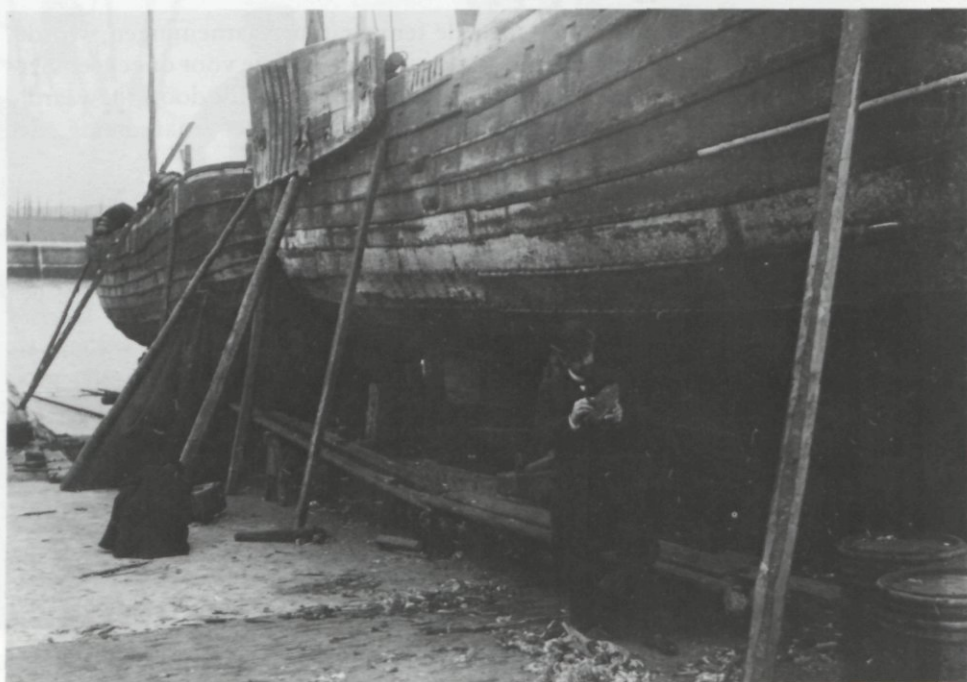
Foto genomen aan het begin van deze eeuw. Twee bomschuiten op de werf te Scheveningen. Redeke is bezig een stuk hout te onderzoeken dat aangetast is door de paalworm.
