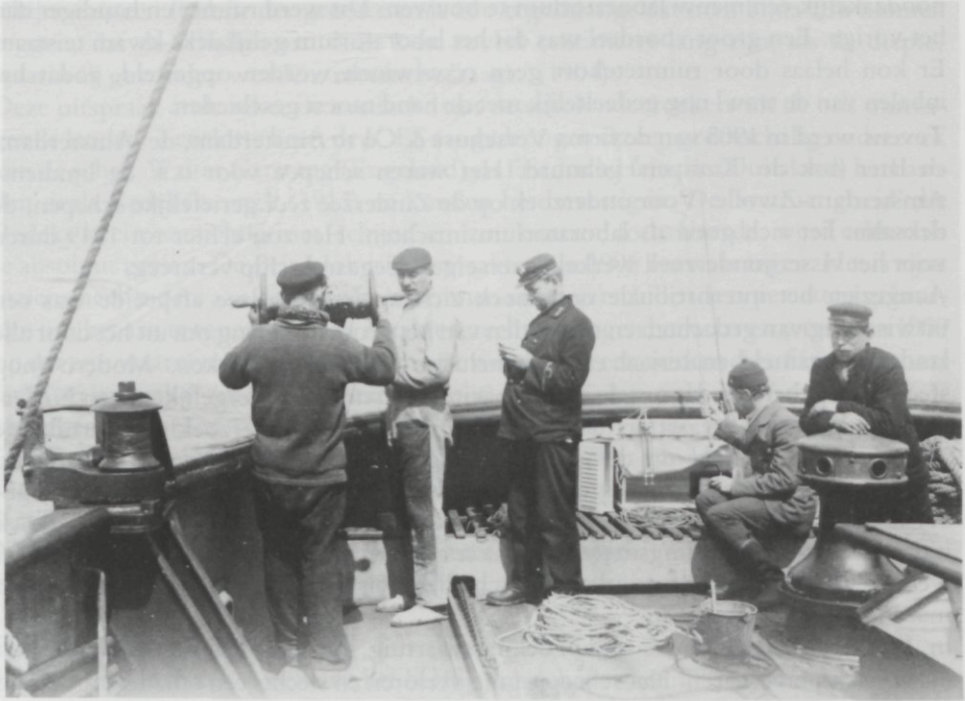
Aan boord van de 'Wodan' werden verschillende oceanografische waarnemingen gedaan. Op deze foto zien wij van links naar rechts de volgende bezigheden en instrumenten. Een handlier gebruikt voor het vieren en halen van de scheepslog. De marine-officier hanteert een chronometer voor de snelheidsbepaling met de log. Een stel Knudsen's kantelthermometers voor het bepalen van de exacte diepte. In de emmer staat een thermometer om de temperatuur van het oppervlaktewater te bepalen. Naast de zittende onderzoeker staat een barograaf voor het registreren van de luchtdruk, terwijl hij een Schalenkreuz-anemometer in de hand houdt om de windsnelheid te bepalen.
