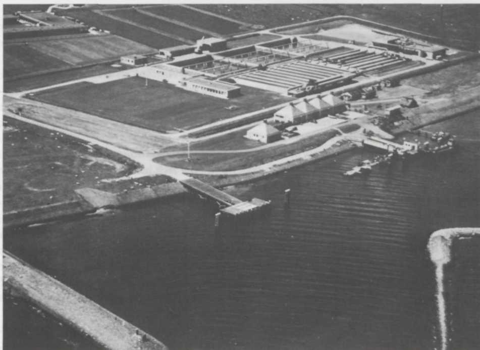
Het Mosselproefstation van het RIVO in de polder 't Hornetje, Texel. Hier werd schelpdieronderzoek uitgevoerd van 1969-1978. De voornaamste taak was een oplossing aan te dragen voor het verwateren (ontzanden) van mosselen in het geval zou worden overgegaan tot de afsluiting van de Oosterschelde. Duidelijk zijn de laboratoriumgebouwen, verwatergoten en bezinkingstanks te zien.
