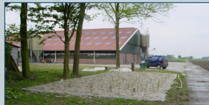
Helofytenfilter voor zuivering afspoelwater in de veehouderij (foto: Waterschap Zuiderzeeland)
